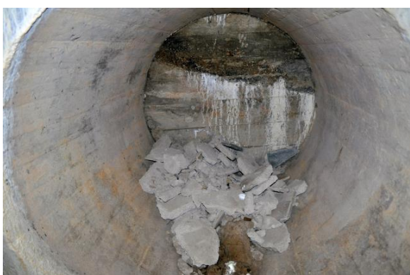
▲ Detail van één van de zes aanwezige betonnen buizen. Sporen van bekisting zijn zichtbaar in de wand en op de bodem. Foto Leo van Midden 2013
