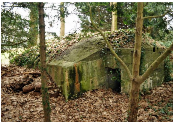
▲ De gevechtsschuilplaats (aangepaste Vf1b Unterstand für 6 Mann) tussen de bomen bij Rhienderinklaan 1. Foto Leo van Midden 2013
