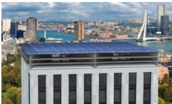
windenergiesysteem met zonnepanelen op het dak
