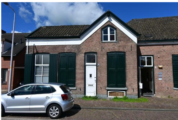
▲◀ Gevels aan de Schoolstraat (links) en aan de Weg naar Voorst (boven). Foto's gemeente Zutphen 2024.
