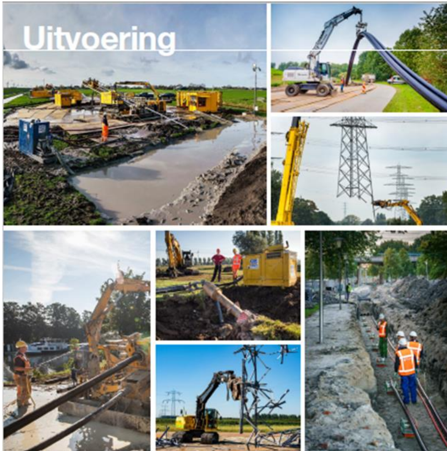
Afbeelding 4: Voorbeeld civiele activiteiten betreffende open ontgraving en horizontaal gestuurde boring
