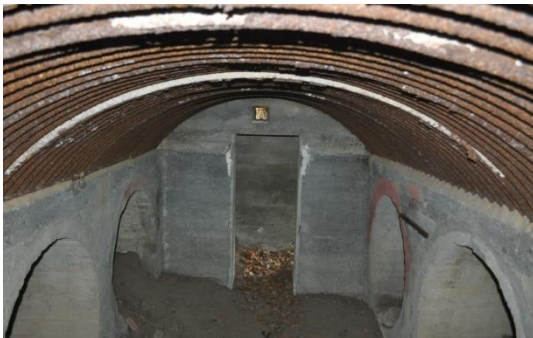
▲ Het interieur van de schuilplaats, let op het 'Wellblech' dak van het type 'Heinrich', de buizen die in het verlengde van elkaar geplaatst zijn en de vierkante opening boven de toegang. Foto Leo van Midden 2013
