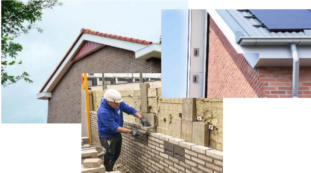
Figuur 3.15 Maatwerk kast in de nok links en geschakelde inbouwkasten met twee invliegstenen rechts.
