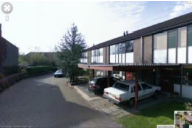
Woningen met carport bij Zwanevlot
