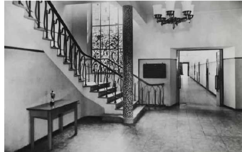
Foto uit 1951 van de entreehal met het hoofdtrappenhuis
